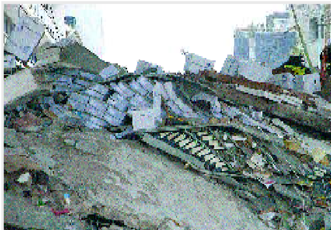
8 Teile der Etagen 5 und 6 lagen oberhalb des Straßenniveaus fast waagrecht übereinander geschichtet. Foto: Stefanie Behrendt.
