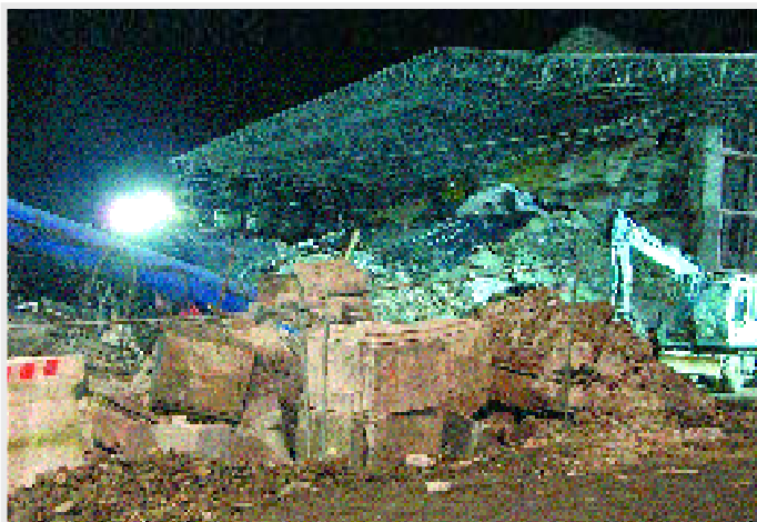
3 Erste Teile des Daches stehen. Da in den ersten Tagen die Statik an und um die Baustelle ein großes Problem darstellte, dauerte der komplette Dachaufbau ungefähr zehn Tage. Foto: Stefanie Behrendt.
