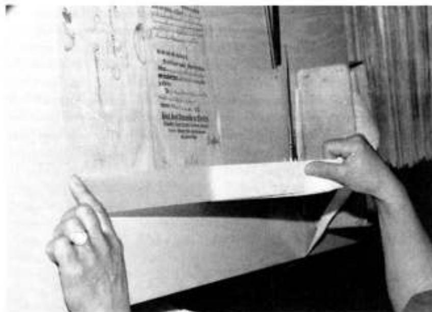
Abbildung 19: Ausbessern mit Filmoplast-P-Streifen
