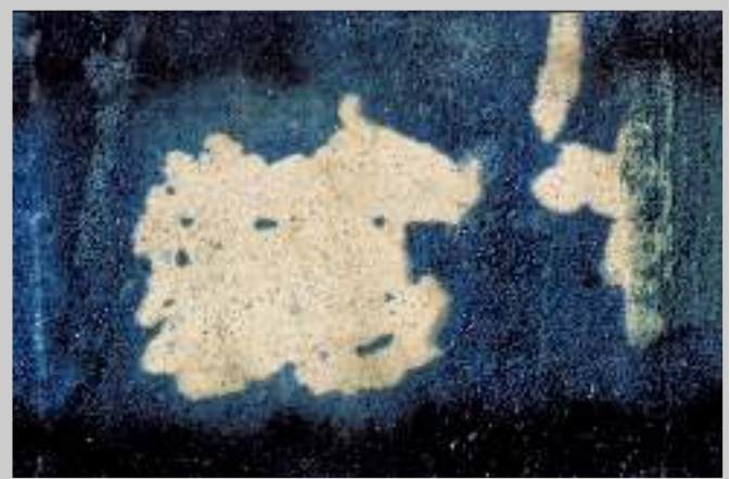
9 Smalte in Casein auf Putz à secco vermalte wird in Schollen abgesprengt.
